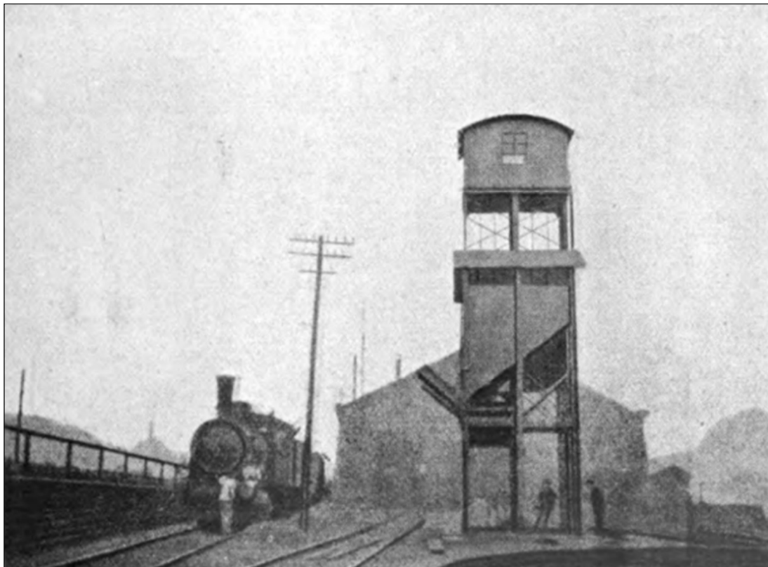
Abb. 6 Der Schlackenaufzug zwischen den Lokomotivschuppen 1 und 2 auf dem Personenbahnhof in Mannheim. Auf dem Foto, publiziert im Jahr 1908, ist hinter dem Schlackenaufzug ein Lokomotivschuppen zu sehen (Zimmermann 1908, 567–572, Fig. 2).
